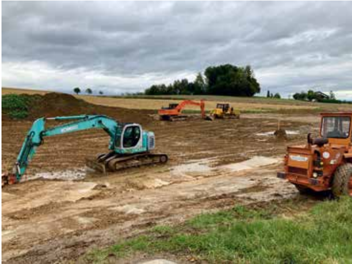
Bau des Rückhaltebeckens im Bereich der Wimberger Höhe (6-2024)
