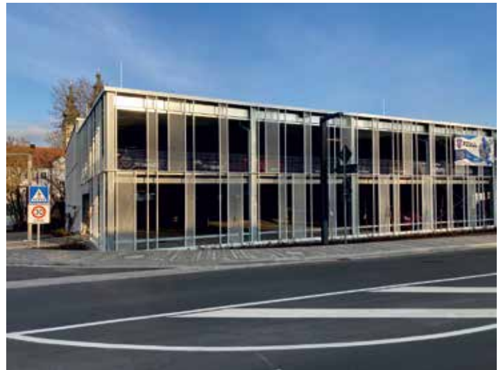
Parkhaus an der Bahnhofstraße (12-2024) (Fotos: JBH)
