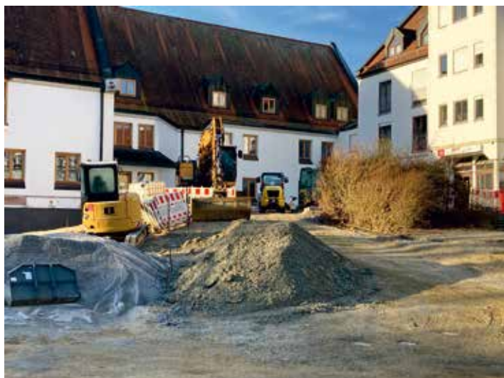
Umbaumaßnahmen im Rahmen des behindertengerechten Zugangs zum Rathaus
